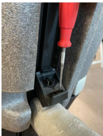
2.1 Schroef de twee delen van de behuizing los met een Torx schroevendraaier.
